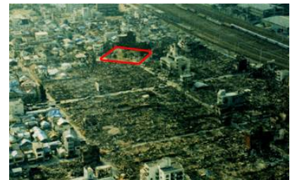
火災の焼け止まり（大国公園）
