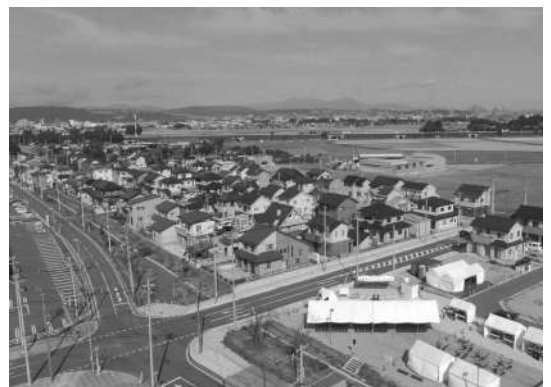
下増田地区移転先団地（美田園北団地）
