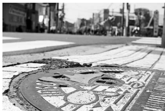
写真1 被災したロボコンマンホール
