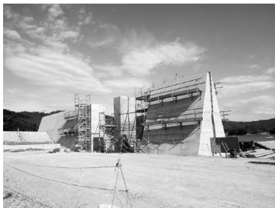
谷川漁港海岸保全施設災害復旧工事（平成28年8月時点）
