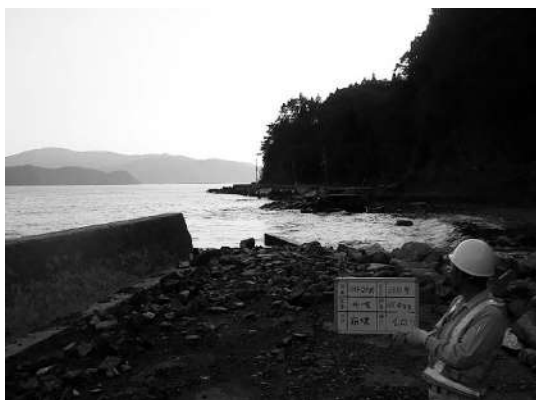
津波により破堤した防潮堤（その2）
