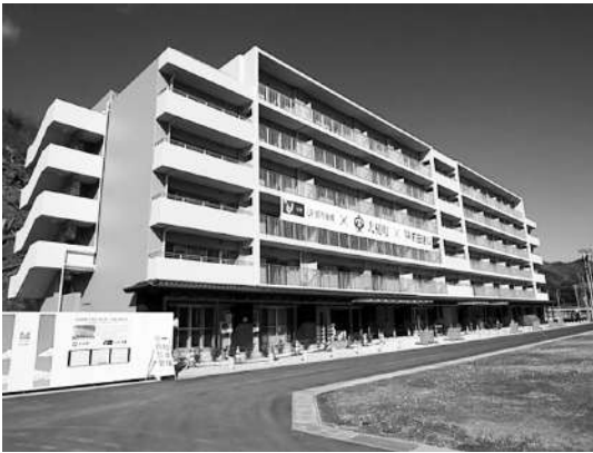
写真1 末広町災害公営住宅（平成28年4月）
