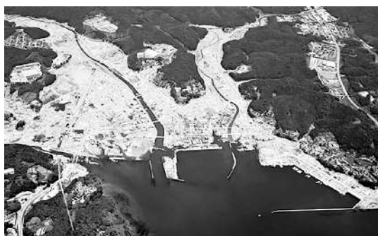
写真2 震災後の南三陸町志津川市街地
