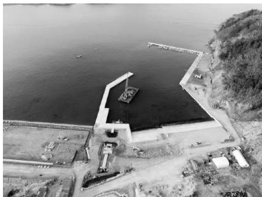
谷川漁港災害復旧工事（平成28年3月時点）
