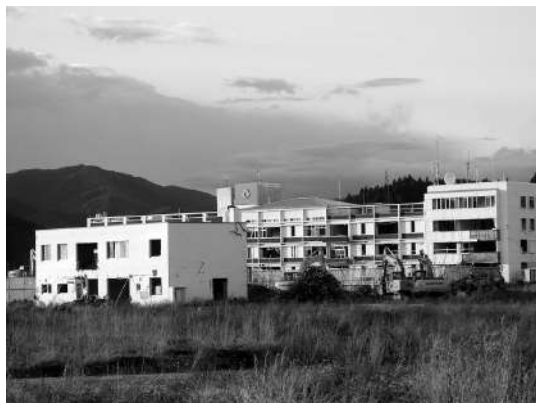
写真1：解体中の陸前高田市役所
