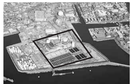
西部処理場周辺の様子
