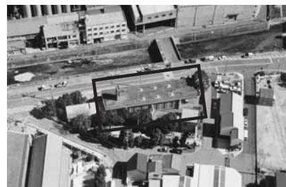
休止中の大石ポンプ場
