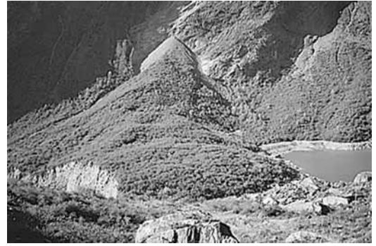
写真-5 天然ダムを形成した大規模崩壊（右側が大海子、水面付近の白い線は3mの水位低下跡、左側のガケ面は決壊場所）
