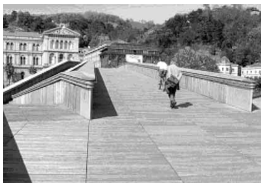
ペドロアルッペ歩道橋
