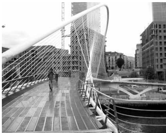
ズビズリ歩道橋と磯崎ゲート
