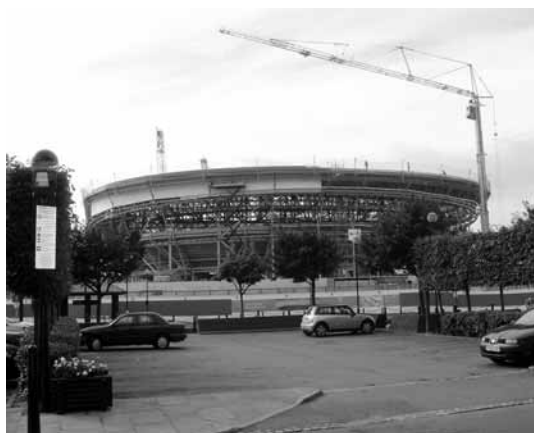
キングスドック工事現場
