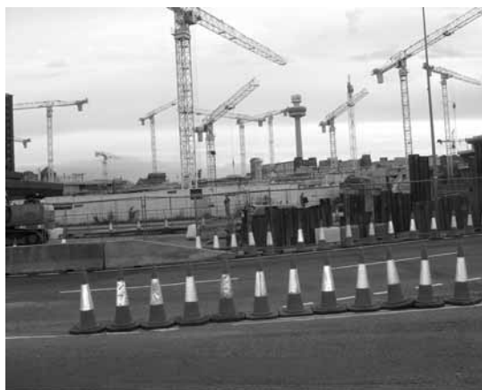
パラダイス地区工事現場
