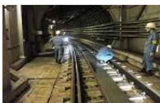
軌道内重点パトロール (施設管理課 保線区)
