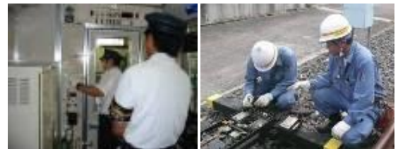
技術の継承（添乗指導、転てつ機の点検）
