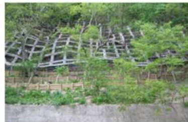
（自然環境に配慮した斜面対策）
