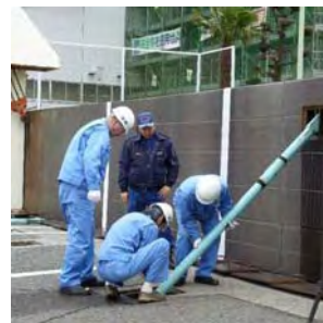
・防潮堤鉄扉閉鎖作業
