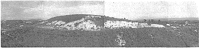
写真 48 霞ヶ丘西方より東を望む (1952年)
