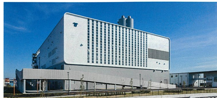
港島クリーンセンター
