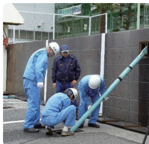
防潮堤鉄扉閉鎖作業
