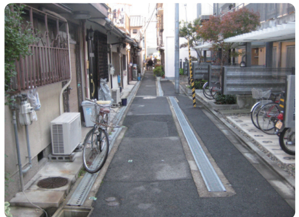
建替えにより、建物が後退し道路が広がっています
