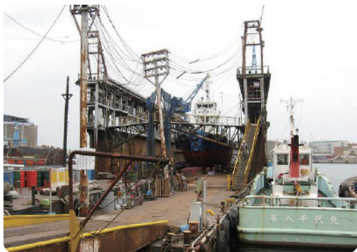
浮ドックでの造船の様子(西出町)
