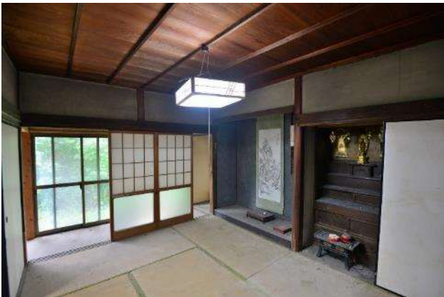
カミノマには奥行き浅い床の間が設けられ、その横に仏壇が眺えられている。床柱は太鼓に落とされた前丸柱で足元は筭目あらわしとなっている。天井には竿縁天井が張られている。
