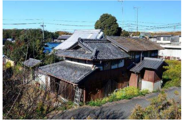
東側の農地や道路からもよく見える。付属棟も入母屋形式の瓦葺屋根、真壁造漆喰塗装といった伝統的な姿を残している。
