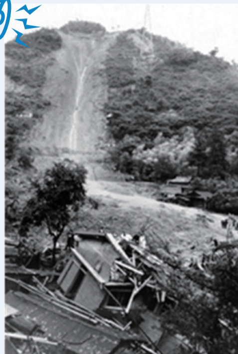
「昭和42年水害」で発生した土砂災害の状況(市ヶ原)
