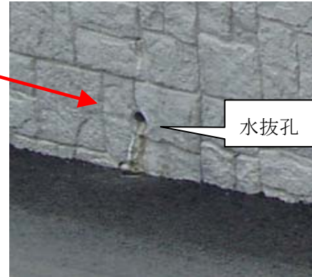
水抜孔付近拡大写真
