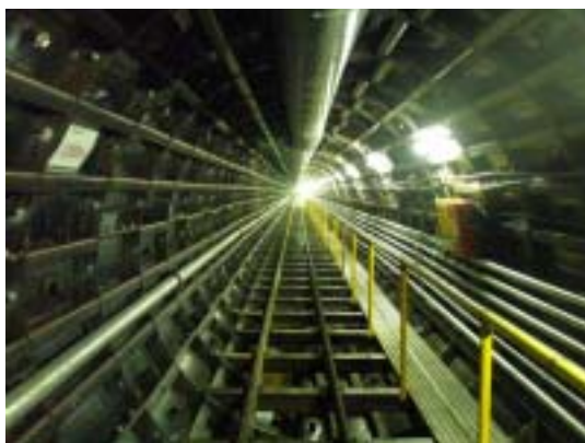
シールド 1 次覆工の状況
