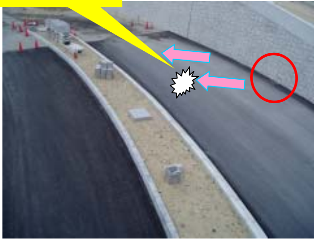
西側擁壁遠景
