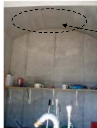
緊急資材庫内
