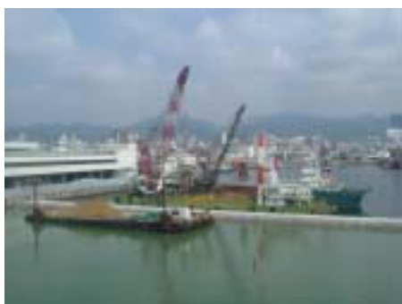
埋立状況 手前から①台船、②瀬取台船、③土運搬船
