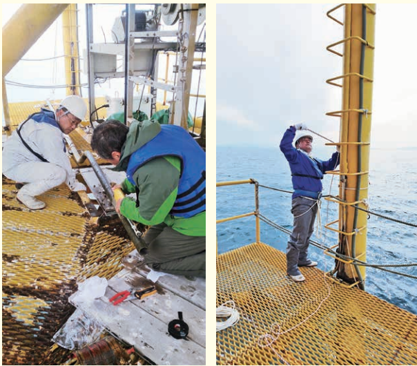
写真2 ↑メンテナンスの様子。約1カ月に1回、メンテナンスを実施
