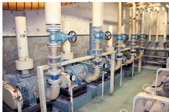
↑各水槽へエアを送る機械が並ぶブロー室
