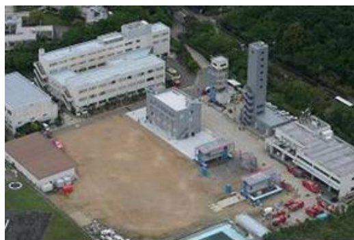
市民防災総合センター
