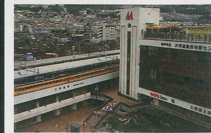
高架化された六甲道駅とメイン六甲
