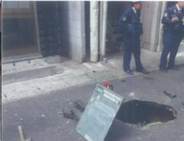
中央区・污水管きよ陥没状況(平成26年4月)
