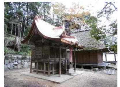
■市指定有形文化財 八幡神社本殿
