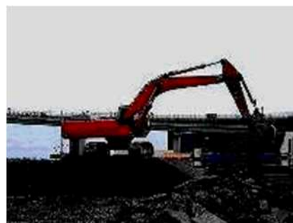
■特定建設作業の状況
