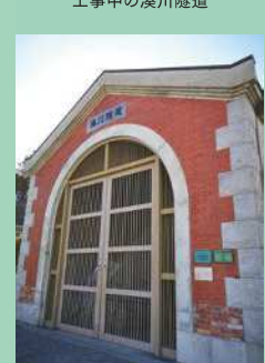
湊川隧道公式WEBサイト http://minatogawa-zuido.com/
