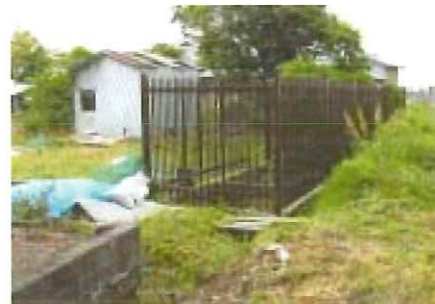
防火水槽の清掃を行う
