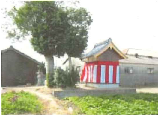
改築工事が行われた(14年9月)
