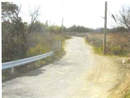
岩ヶ谷付近の道路：整備したいが登記ができていない
