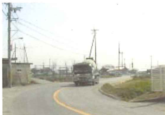
大型車の通行が多い県道：カーブで見通しが悪いため、標識・横断歩道を設置したい
