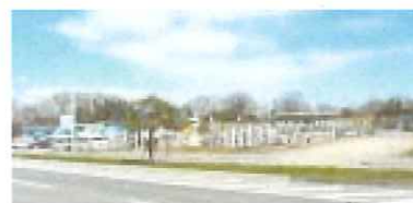
神戸母里線沿いの資材置場
