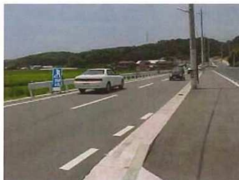
写真 3-3 市道西戸田・中村線(拡幅工事中)
