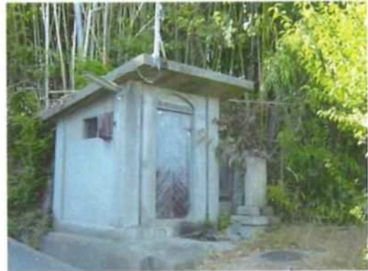
写真 2-7 簡易水道の取水口
