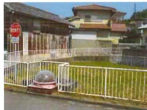
写真. 防火水槽
