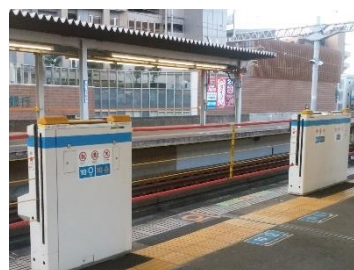
ホームドア（昇降式ホーム柵・六甲道駅）
